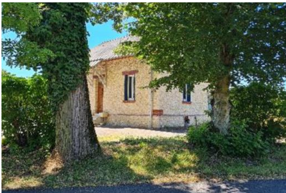
Pavillon Service de Réparation Pénale : 37 rue de la Chacatière à LEVES
